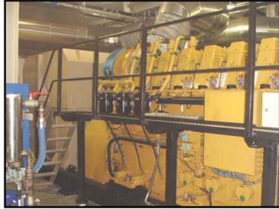
Abb.: 5: Hauptmotor Nr. 1 der Teso-Fähre
